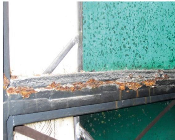
Durch Rost verformte Rahmenleiste eines Fensterfeldes
