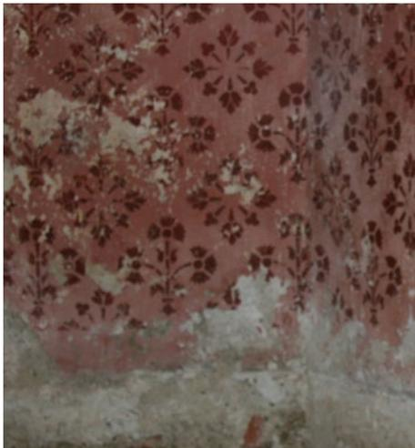
Durch aufsteigende Feuchtigkeit im Mauerwerk sind bodennahe Wandmalereien besonders gefährdet
